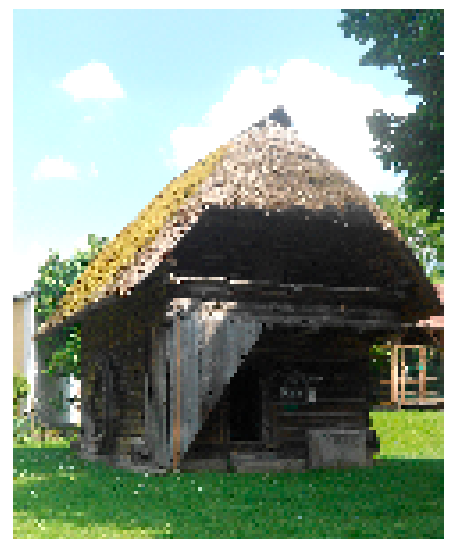
Troadkasten aus Aschbach (Windfeld) 17. Jhd., Blockbauweise, Tanne als Bauholz, Schwellenkranz Eiche, bemerkenswerte konstruktive Details
