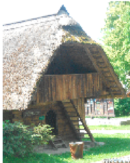
Troadkasten aus Kürnberg (Briefberg) 17. Jhd., Blockbauweise, in Tanne ausgeführt mit Ausnahme des eichenen Schwellenkranzes, durchgehender Steinsockel. Das mit Stroh gedeckte Dach ist als Pfettendachkonstruktion mit Schopfwalm ausgeführt.
