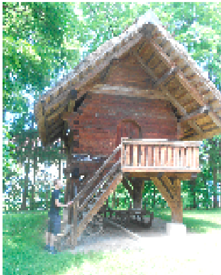
Troadkasten aus Ertl (Peilstein) 18. Jhd., in Blockbauweise errichtet, von 4 Ecksäulen getragen, ist einer der wenigen, in seiner ursprünglichen Form erhaltenen Bauwerke dieser Art in NÖ
